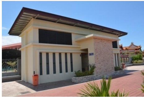
Gambar 55: Kemudahan tandas awam memberi keselesaan kepada pengguna taman. Sumber : Papar Waterfront, MDPPR.
